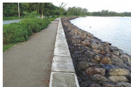
Figure 2. La défense lourde. Cet exemple, à l'île Maurice, montre le couplage d'un mur anti-submersion et d'un cordon d'enrochement pour protéger une route côtière de l'érosion et de la submersion.
